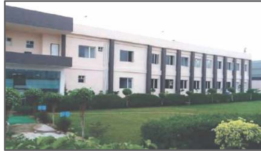
MAHLOTRA CABLES (Unit 2) - MANESAR (Hr.)
